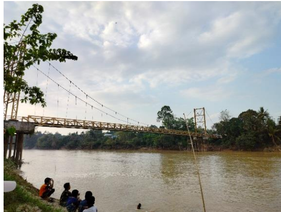
Gambar 5. Jembatan Gantung Desa Pauh Ranap
